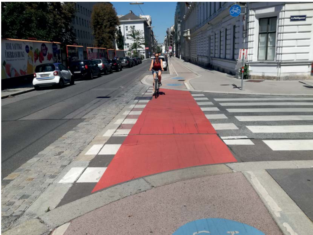
Abbildung 7: Praxisbeispiel flächiger Bodenmarkierung einer nicht abgesetzten RFÜ
