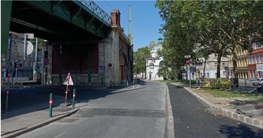
Abbildung 81: Abzweigung von der Nebenfahrbahn des Inneren Währinger Gürtels 499
