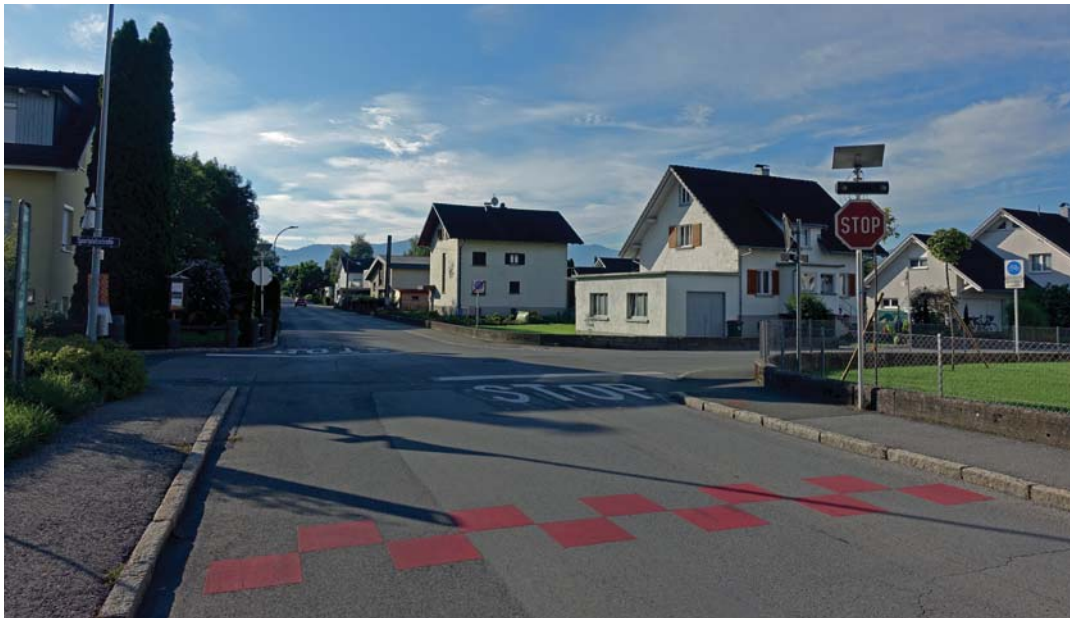
Abbildung 71: Gestaltung einer Kreuzung der Fahrradstraße Wallstraße – Sportplatzstraße 474
