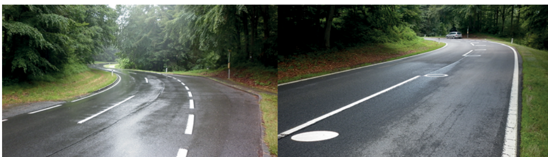
Abbildung 20: Untersuchungsstelle bei km 7,7 der B56 vor und nach Aufbringung der Markierung
