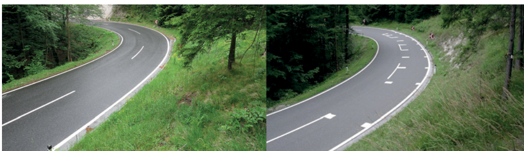
Abbildung 21: Untersuchungsstelle bei km 62,30 der B21 vor und nach Aufbringung der Markierung
