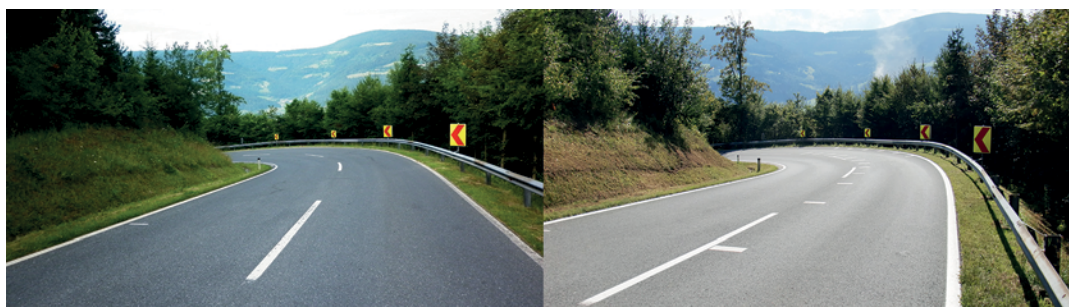
Abbildung 23: Untersuchungsstelle bei km 2,25 der B69 vor und nach Aufbringung der Markierung
