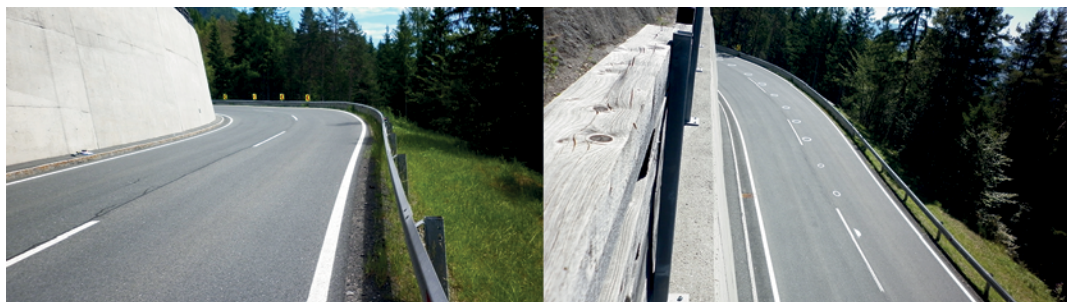
Abbildung 25: Untersuchungsstelle bei km 9,84 der B87 vor und nach Aufbringung der Markierung
