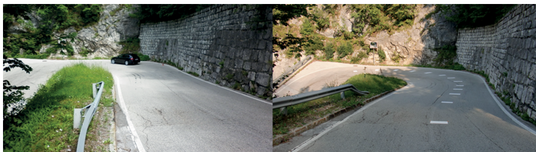
Abbildung 26: Untersuchungsstelle bei km 20,91 der B91 vor und nach Aufbringung der Markierung
