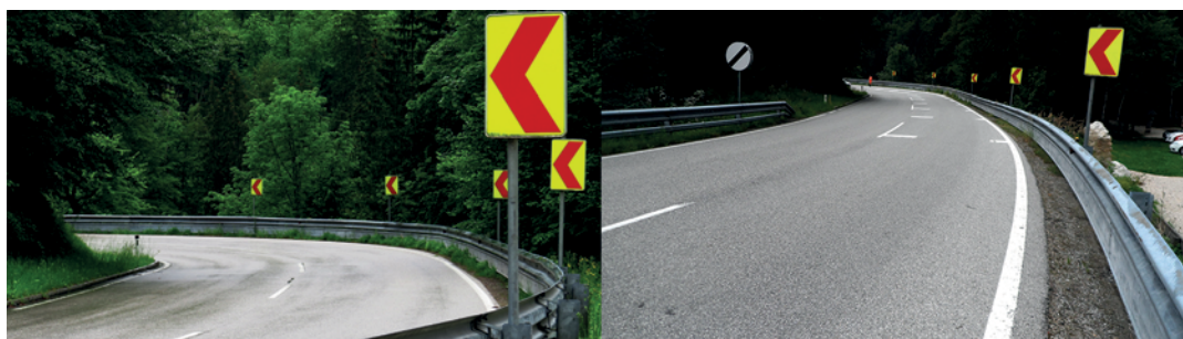
Abbildung 22: Untersuchungsstelle bei km 67,10 der B25 vor und nach Aufbringung der Markierung
