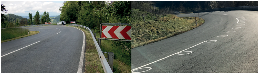
Abbildung 24: Untersuchungsstelle bei km 111,9 der B70 vor und nach Aufbringung der Markierung
