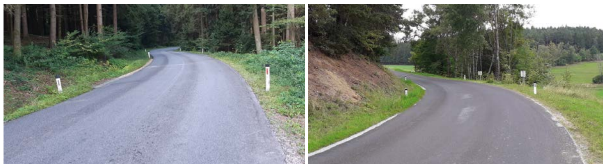
ABBILDUNG 33: Beispiele von Unfallstellen auf Landesstraßen mit 6,0 m Querschnittsbreite ohne Mittel- und Randmarkierungen; Fotos: KfV Sicherheit-Service GmbH
