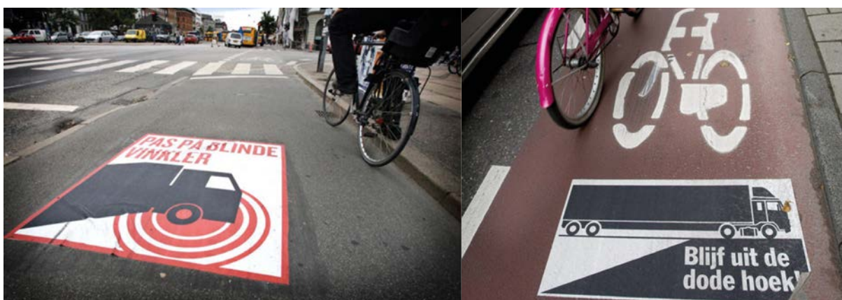
ABBILDUNG 51: Beispiele für Hinweismarkierungen zur Warnung vor dem toten Winkel: Kopenhagen (links; Quelle: Avisen 2015) und Niederlande (rechts; Quelle: Truckstar 2014)
