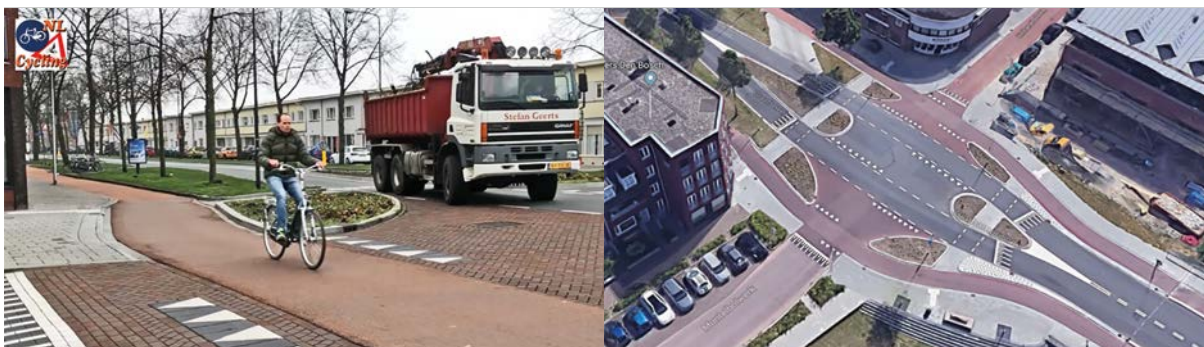
ABBILDUNG 44: Beispiel für eine abgesetzte Führung des Radwegs: 's-Hertogenbosch, Niederlande (Quelle: Bicycle Dutch 2018)
