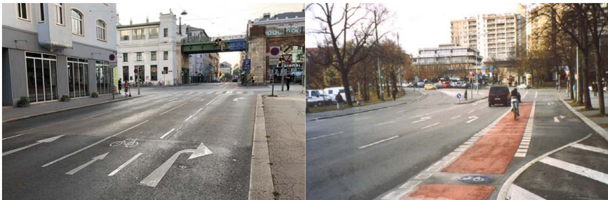
ABBILDUNG 47: Beispiele für die Führung von Radfahrstreifen links der Rechtsabbiegespur: Wien (links; Foto: KFV) und Berlin (rechts; Quelle: Horn et al. 2015: 34)
