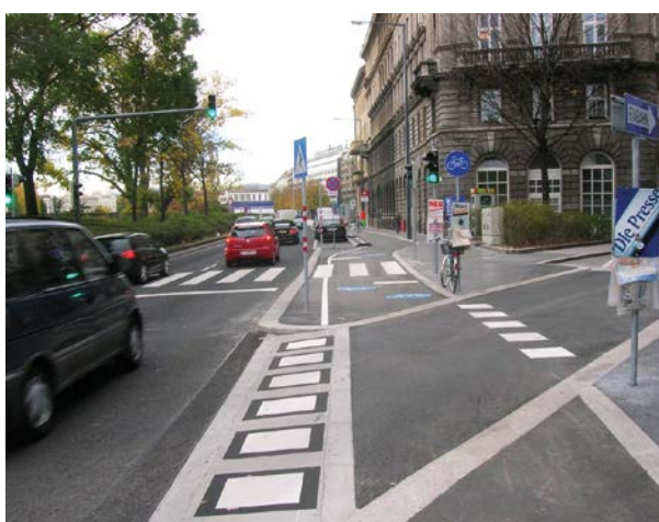
ABBILDUNG 46: Beispiel für eine Fahrbahnanhebung (Quelle: Robatsch 2015: 14)
