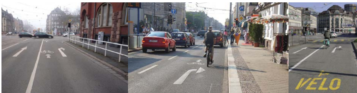
ABBILDUNG 40: Beispiel für gemeinsame Fahrstreifen für geradeaus fahrende Radfahrer und rechts abbiegende Kfz: Heidelberg (links; Quelle: Horn et al. 2015: 35), Leipzig (Mitte; Quelle: Horn et al. 2015: 35) und Schweiz (rechts; Quelle: ASTRA 2009: 36)
